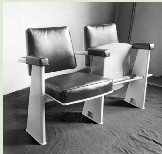
Université de Paris, faculté de médecine (L. Madeline et J. Walter, arch., 1952-1953). Montage des sièges d'un amphithéâtre, 1953. Ossature en tôle d'acier pliée, tables et banquettes fixes en bois massif.
