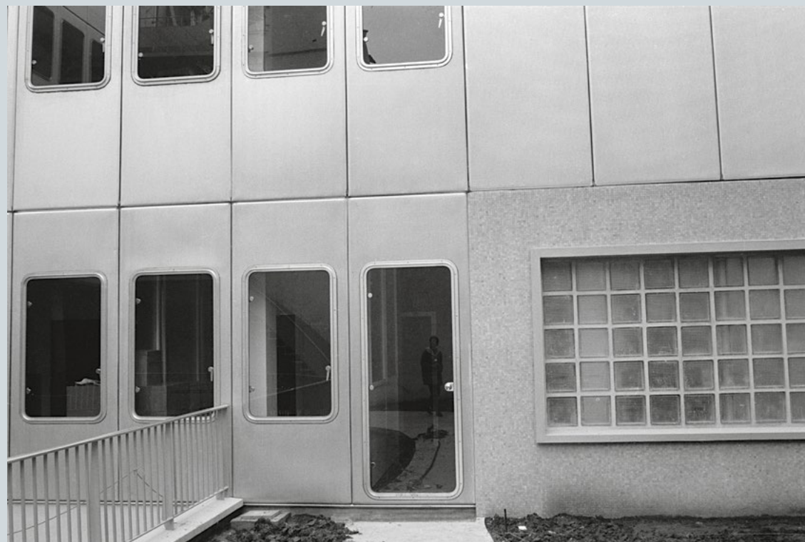
1. Usine CIMT, Valenciennes. Montage des panneaux conçus par Jean Prouvé, 1963.
