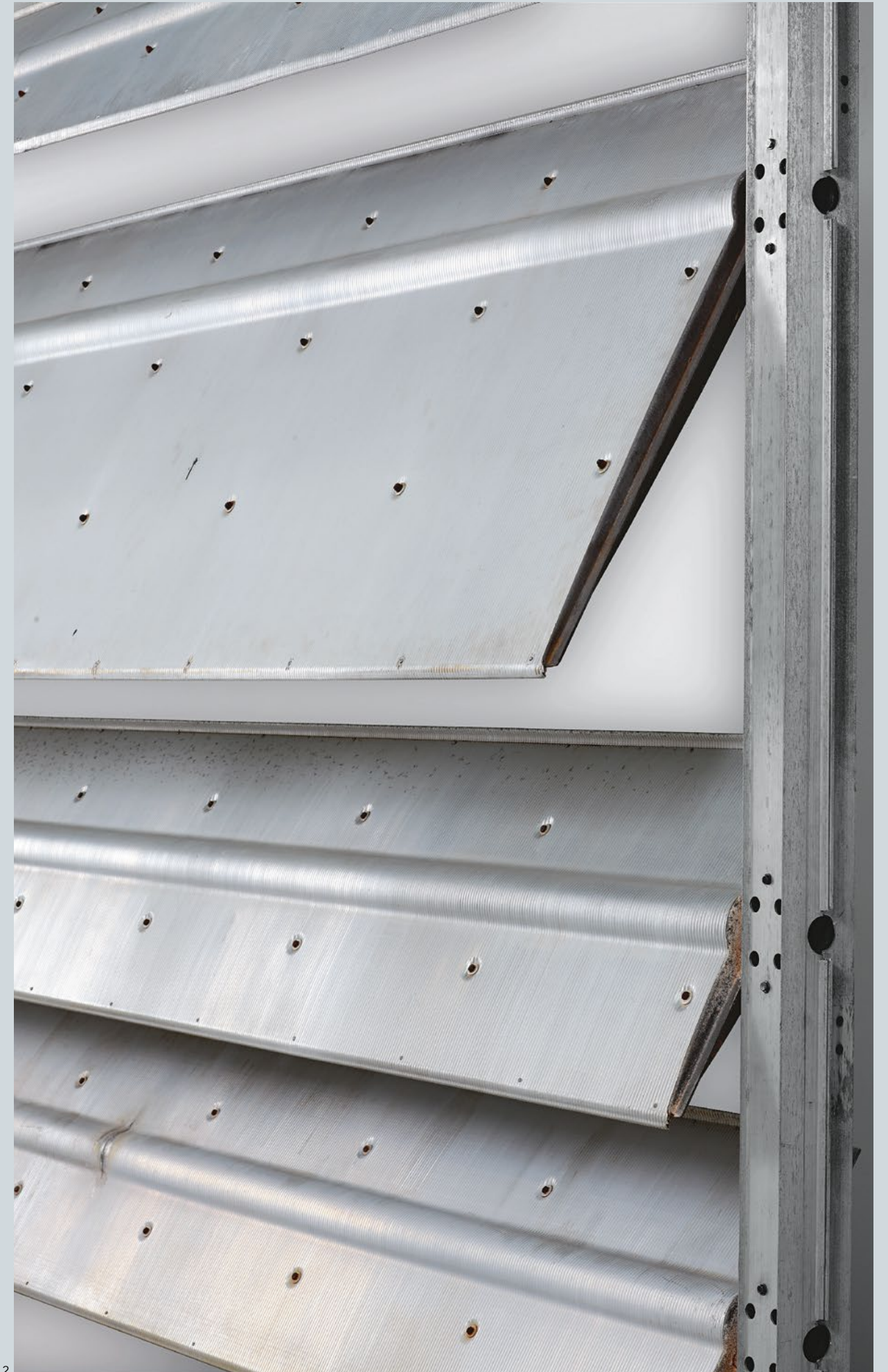
2. Panneau de façade brise-soleil à lames orientables en tôle d'aluminium, 1953.
