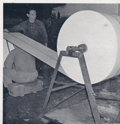
Realizzazione della linea lunga 7.200 metri
